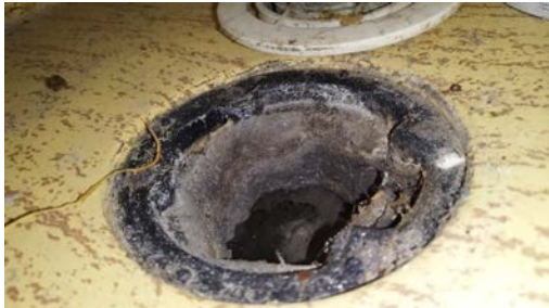
Kontroll av sluken.
