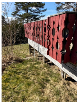
Gulvbord helt inn mot bordkledning
