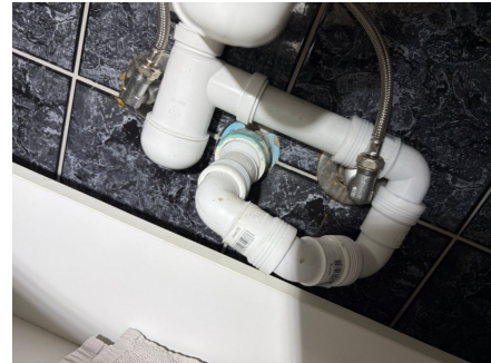
Rørgjennomføring i vegg under servant
