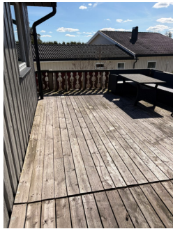
Gulvbord helt inn mot bordkledning
