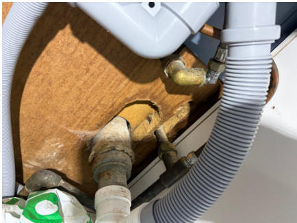
Åpning i vegg under benkeplate
