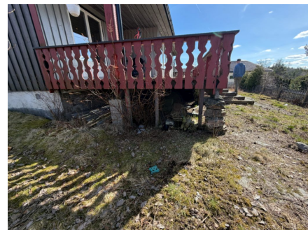
Fundamenter av stein og murblokker.
