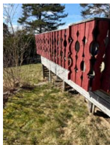
Gulvbord helt inn mot bordkledning
