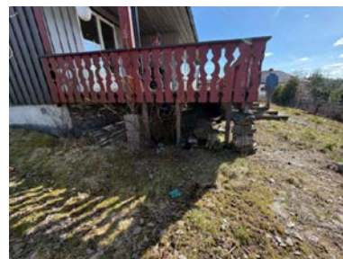
Fundamenter av stein og murblokker.
