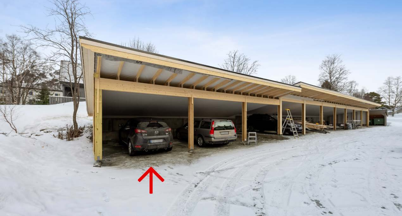
Parkering i nyoppført carport
