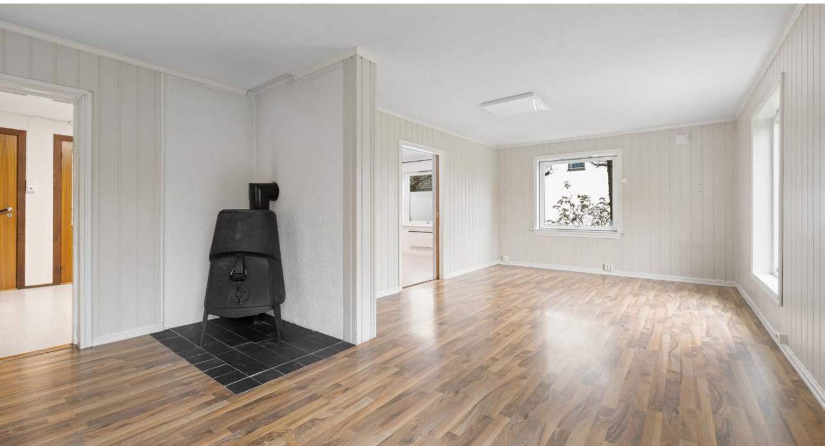
I stuen er det både Jøtul vedovn og varmepumpe, for oppvarming.
