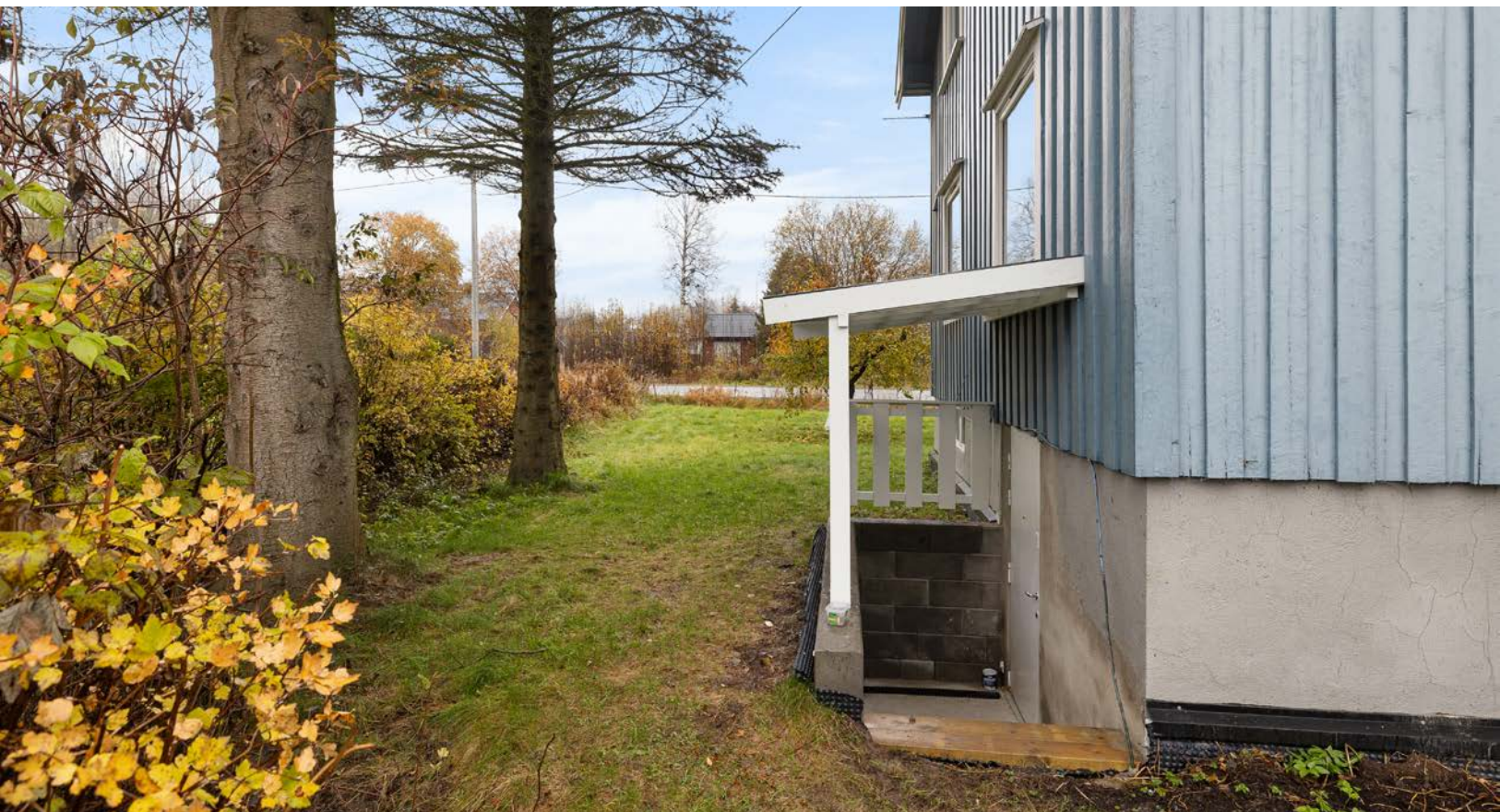
Utvendig adkomst til kjelleren.
