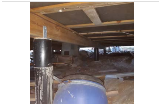
Bjelkelag med stubbloftsplater
