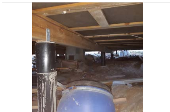
Bjelkelag med stubbloftsplater
