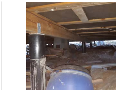
Bjelkelag med stubbloftsplater
