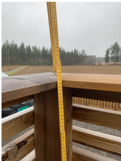
Høyde rekkverk.
