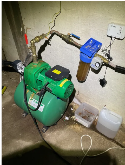
Stoppekran og vannpumpe.
