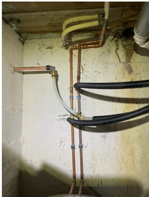
Vannrør i kjeller.
