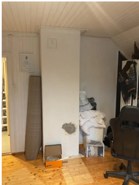
Pipe på loft.
