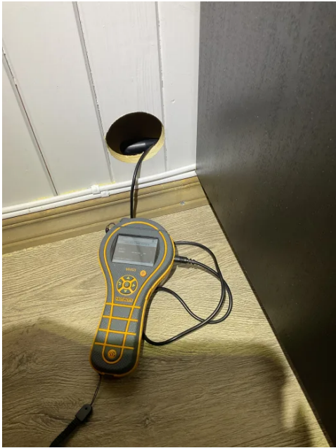
Hulltaking i tilstøtende rom.
