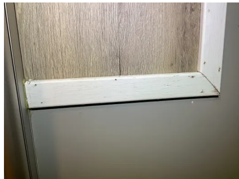
Fuktskader
