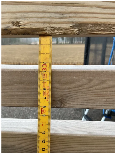
Avstand mellom spiler i rekkverk.
