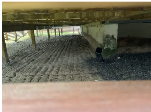
Taknedløp er avsluttet over terreng.
