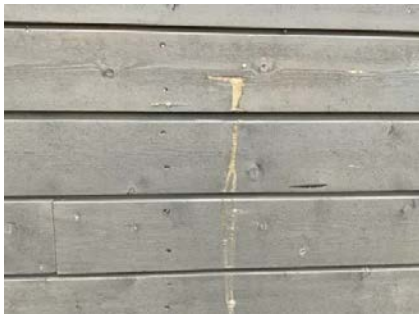
Utslag av kvæ.
