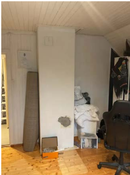
Pipe på loft.
