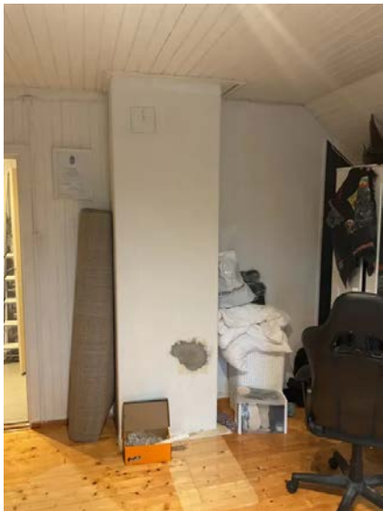
Pipe på loft.
