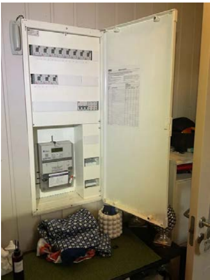
Sikringskap i gang.
