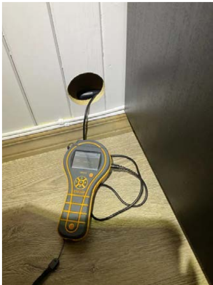
Hulltaking i tilstøtende rom.
