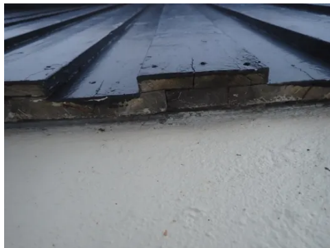
Oversikt oppunder kledning.
