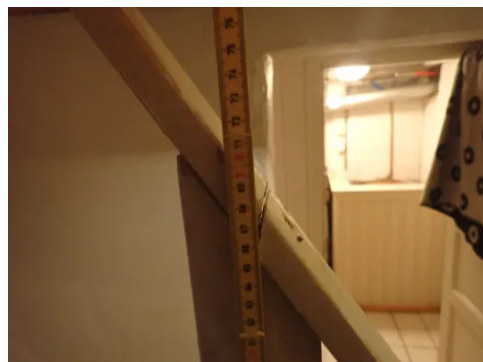
Rekkverkshøyde < 90 cm.
