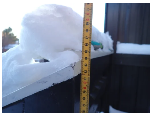
Rekkverkshøyde < 90 cm.
