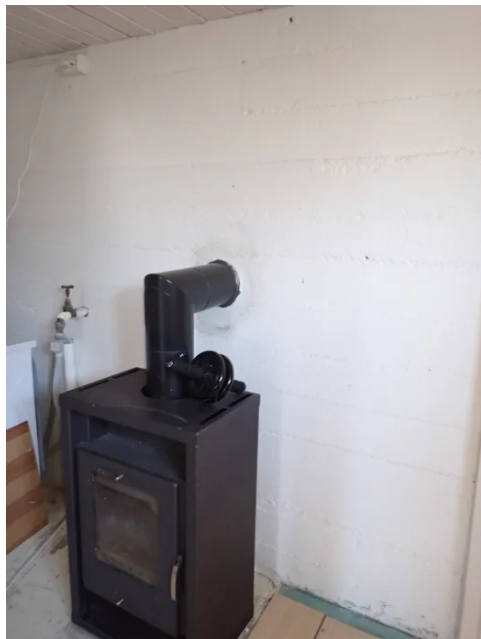
Støpt betongvegg som skjuler 1 side på pipe.
