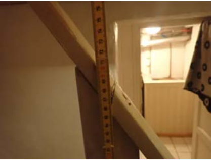
Rekkverkshøyde < 90 cm.
