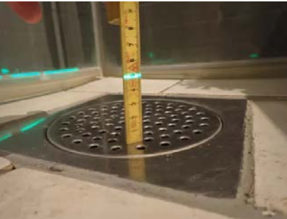
Referansenivå laser til topp tettesjikt ved dør = ca. 50 mm. Viser at høydeforskjell mellom topp tettesjikt ved dør og topp slukrist er tilnærmet det samme.
