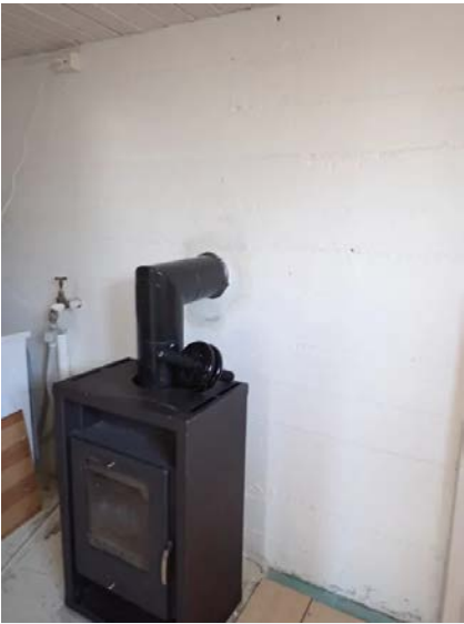
Støpt betongvegg som skjuler 1 side på pipe.
