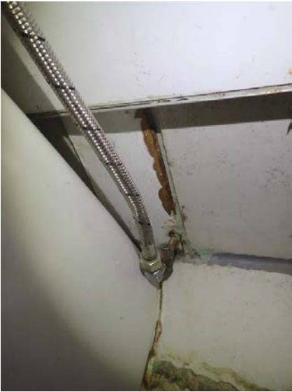
Uegnet materiale i våtsone (bak klosett).
