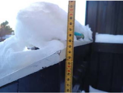
Rekkverkshøyde < 90 cm.
