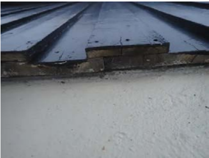
Oversikt oppunder kledning.
