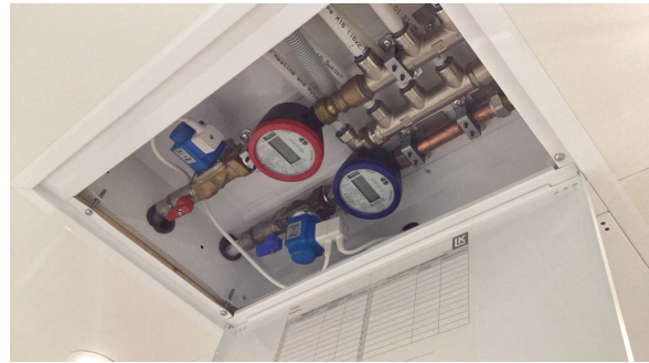
Fordelerskap i himling i gang.
