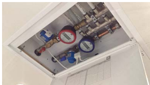
Fordelerskap i himling i gang.
