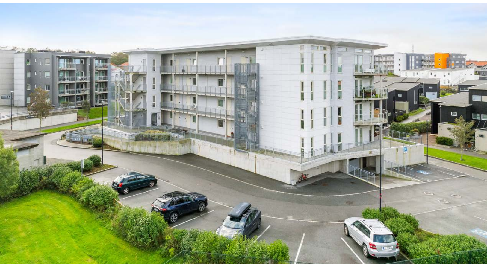
Gjesteparkering og innkjøring til garasjeanlegg
