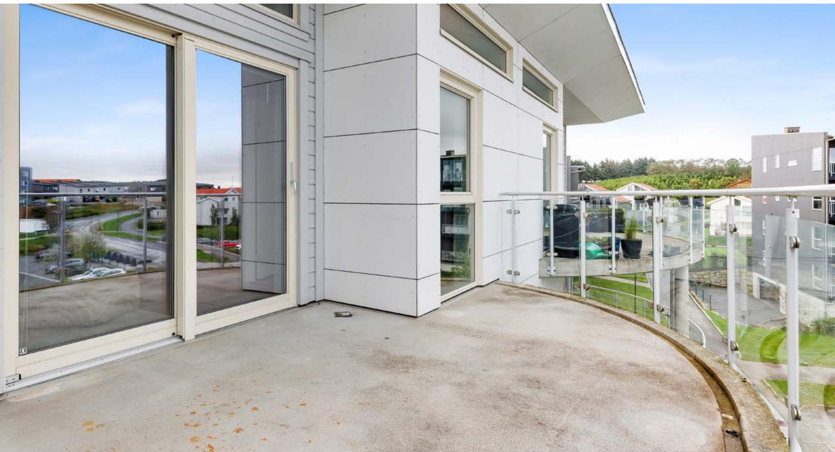
Romslig balkong/veranda med glassrekkverk
