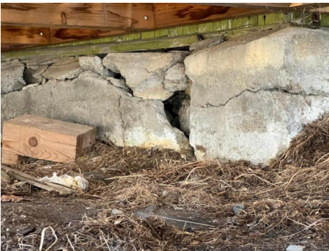
Deformasjoner av mur
