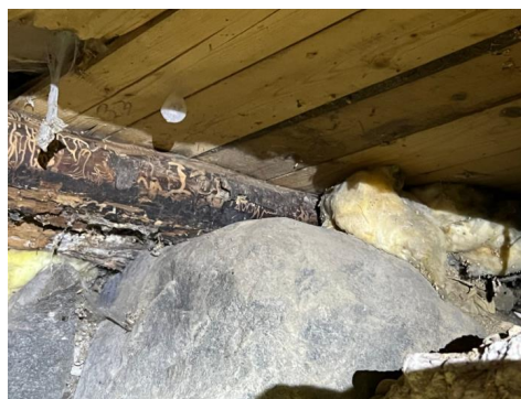
Råte i bunnstokk/bærebjelke
