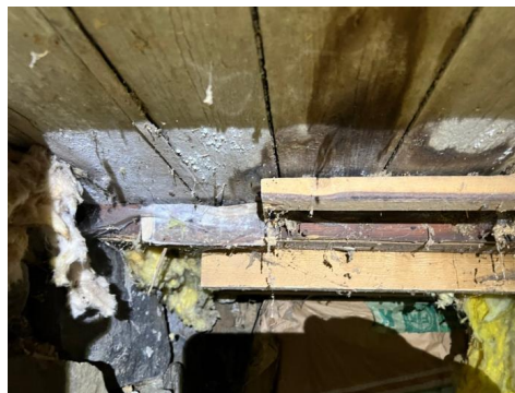
Råte i bunnstokk/bærebjelke
