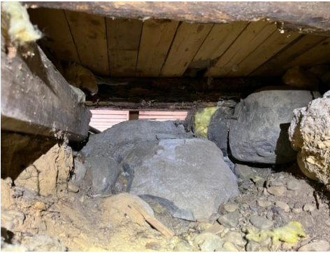
Deformasjoner av mur
