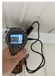
Fuktskjolder over vindu i stue, ved fuktmåletaking var det ikke fuktutslag
