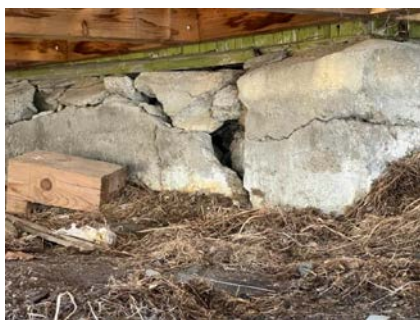
Deformasjoner av mur
