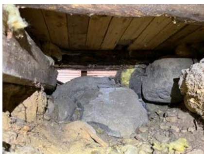
Deformasjoner av mur
