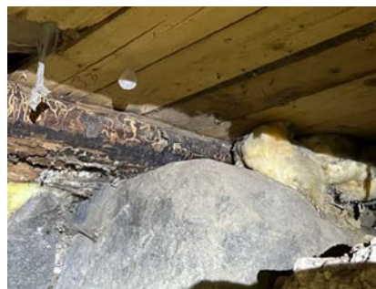
Råte i bunnstokk/bærebjelke
