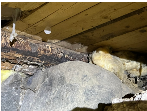
Råte i bunnstokk/bærebjelke
