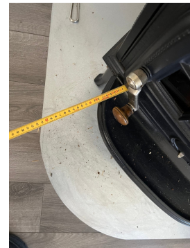
For kort plate på gulv foran ovn ihenhold til krav om avstand til brennbart materiale
