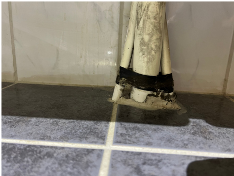
Ikke registrert mansjett i rørgjennomføring/sluk
