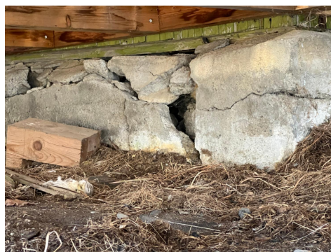
Deformasjoner av mur
