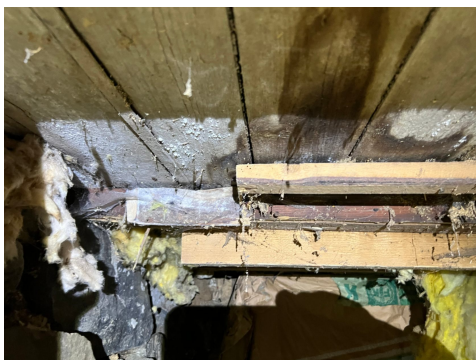
Råte i bunnstokk/bærebjelke
