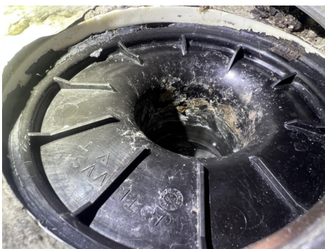
Ikke registrert mansjett i rørgjennomføring/sluk
