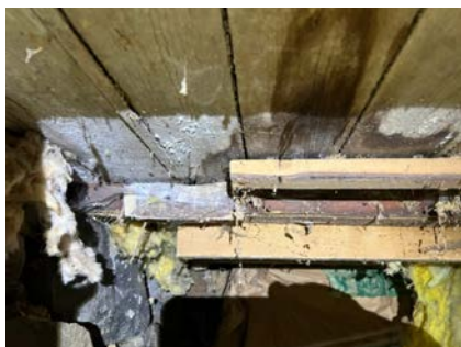
Råte i bunnstokk/bærebjelke
