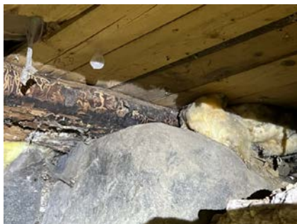
Råte i bunnstokk/bærebjelke
