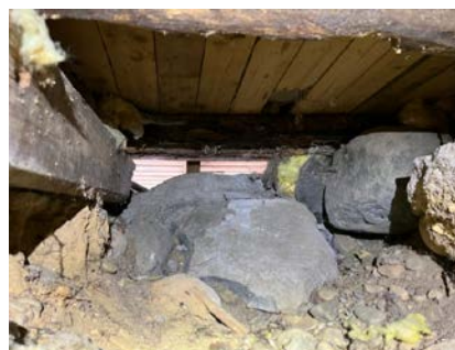
Deformasjoner av mur
