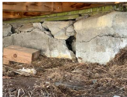
Deformasjoner av mur
