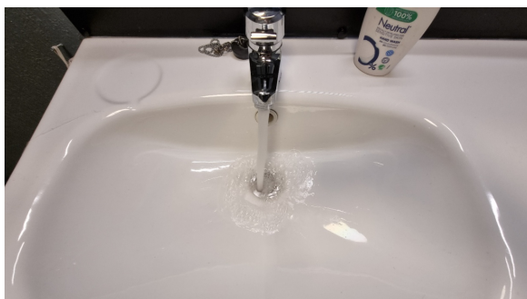
Kontroll av vanntrykk og avrenning.
