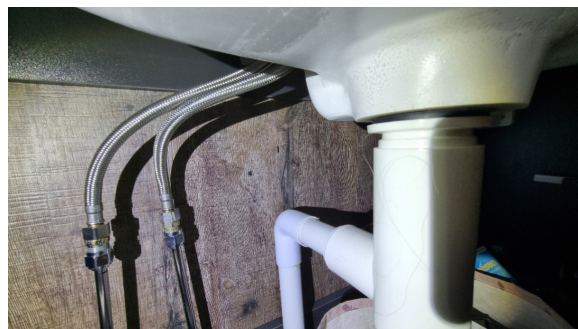
Kontroll av røropplegg under servanten.
