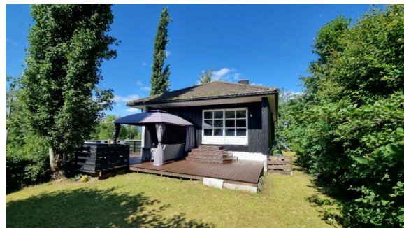
Terrasse oppført utenfor fasade sør.
