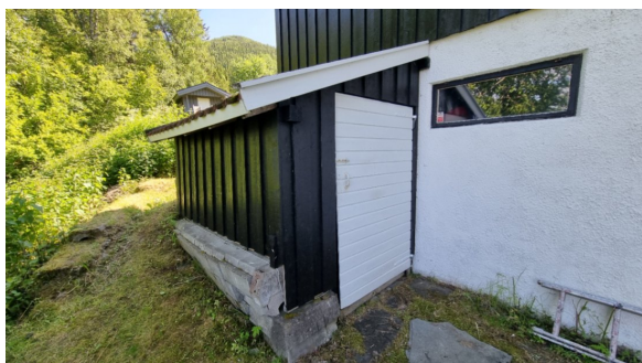
Entre/bod utenfor fasade nord.
