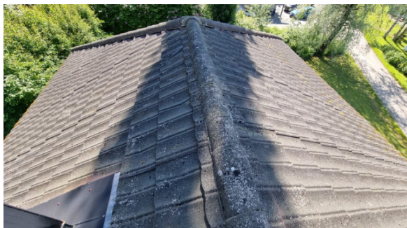
Visuell besiktelse av taket.
