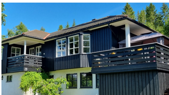
Kjøkkenbalkong til venstre i bildet og terrasse/veranda til høyre i bildet.
