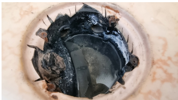
Kontroll av sluk.
