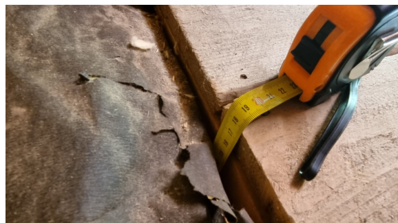
Maling av isolasjonen i loftskillet.
