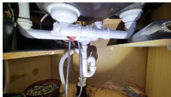
Kontroll av røropplegg under oppvaskkummen.
