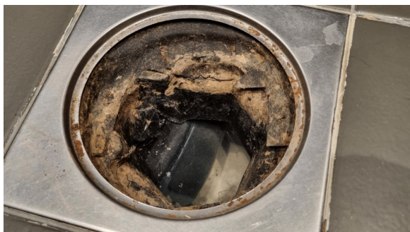
Kontroll av sluk.
