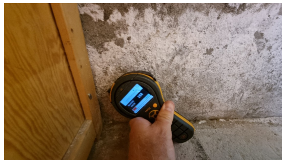
Fuktmåling i gulv.
