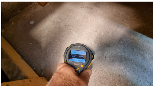
Fuktmåling i vegg.
