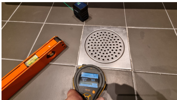
Fuktmåling og kontroll av fall mot sluk.
