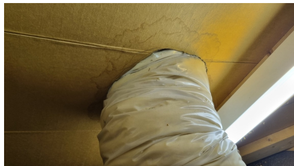
Fuktmerker ved ventilasjonskanal fra kjøkkenet. Det ble fuktmålt her ved befaring, ingen unormale fuktverdier ble registrert.
