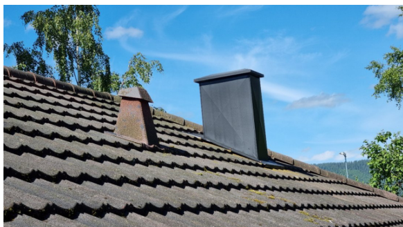
Luftehatter på taket.
