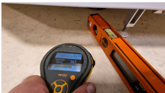
Fuktmåling og kontroll av fall mot sluk.
