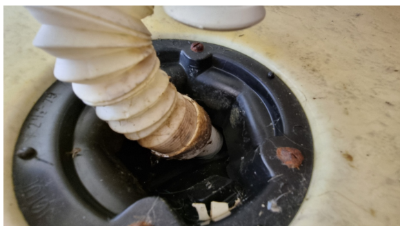
Kontroll av sluk.
