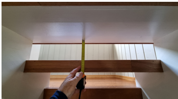
Måling av lysåpninger i opptrinn.
