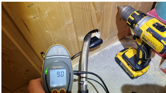
Hulltaking utført i yttervegg under trappen.
