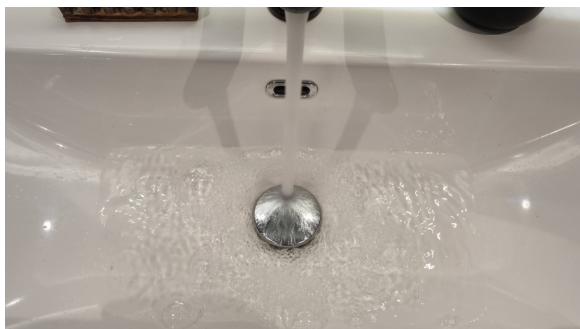
Kontroll av vanntrykk og avrenning.
