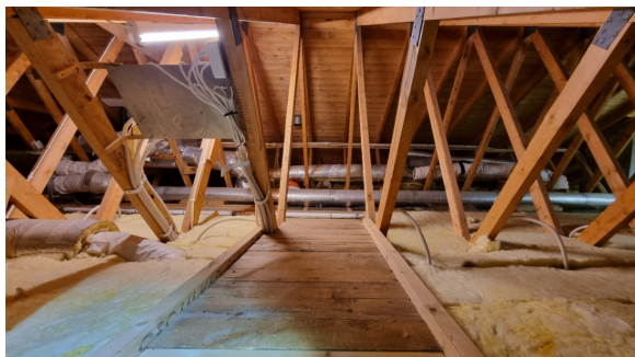
Inspeksjon av kaldloftet.
