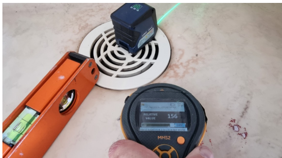
Fuktmåling og kontroll av fall mot sluk.
