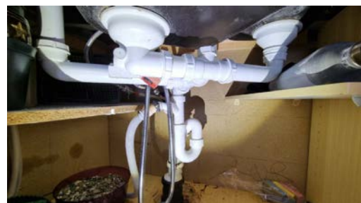
Kontroll av røropplegg under oppvaskkummen.
