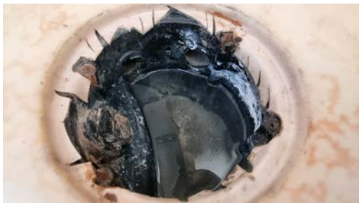
Kontroll av sluk.
