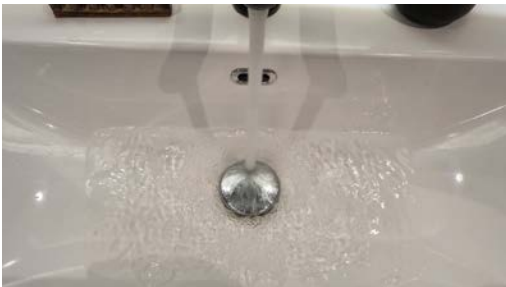
Kontroll av vanntrykk og avrenning.
