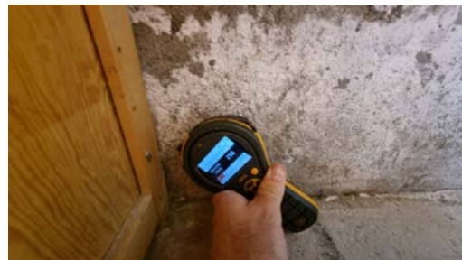
Fuktmåling i gulv.
