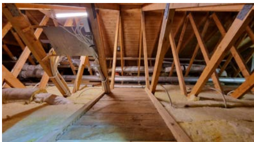
Inspeksjon av kaldloftet.
