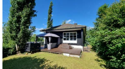
Terrasse oppført utenfor fasade sør.
