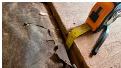
Maling av isolasjonen i loftskillet.
