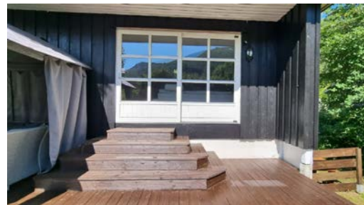
Terrassedør i stuen.
