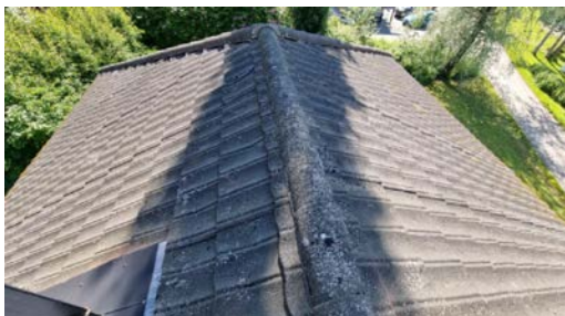
Visuell besiktelse av taket.
