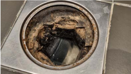
Kontroll av sluk.
