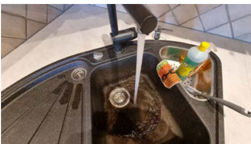
Kontroll av vanntrykk og avrenning.
