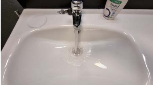
Kontroll av vanntrykk og avrenning.
