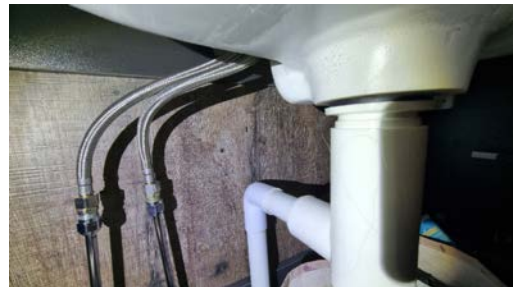
Kontroll av røropplegg under servanten.
