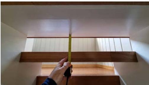
Måling av lysåpninger i opptrinn.
