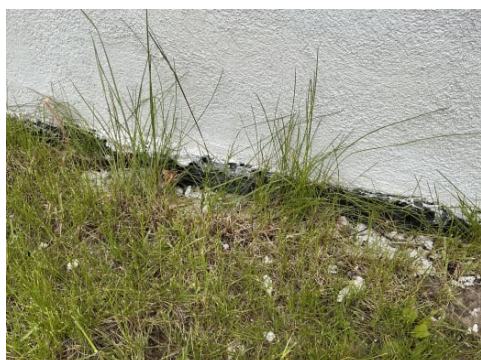
Grunnmurs-plast er synlig på del av grunnmur. Topplist er ikke montert.
