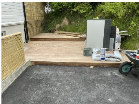
Rekkverk på trapp er ikke montert.
