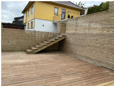
Rekkverk på trapp er ikke montert.
