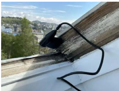
Fukt/råte på takvindu.
