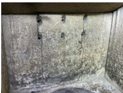
Riss/sprekk på stien i brennkammer på vedovn i kjeller TG 2.
