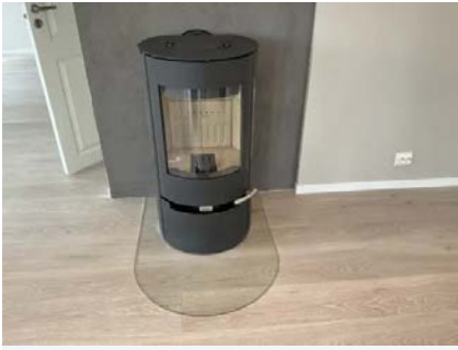
Ny vedovn i 1 etasje.
