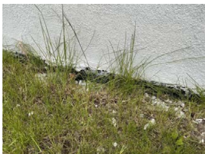
Grunnmurs-plast er synlig på del av grunnmur. Topplister er ikke montert.
