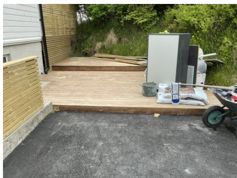
Rekkverk på trapp er ikke montert.
