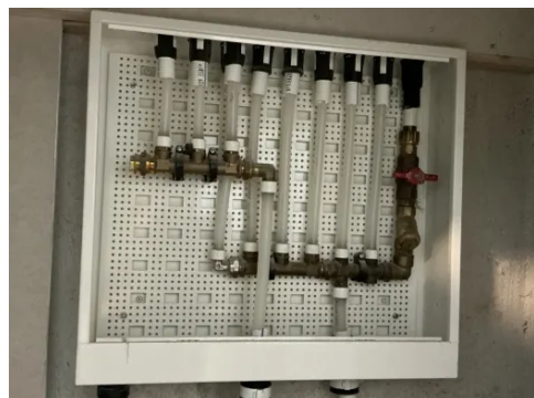
Rør-fordeling i rør i rør skap er ikke merket.
