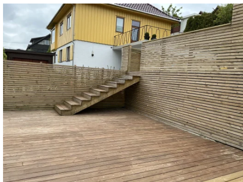
Rekkverk på trapp er ikke montert.
