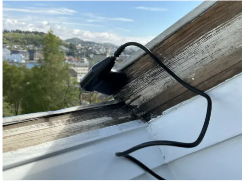
Fukt/råte på takvindu.
