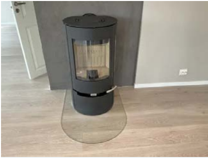
Ny vedovn i 1 etasje.
