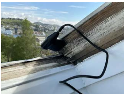
Fukt/råte på takvindu.
