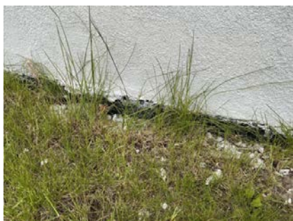
Grunnmurs-plast er synlig på del av grunnmur. Toppliste er ikke montert.
