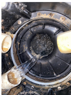
Plastsluk med klemring. Underliggende membran med synlig membran under klemring.
