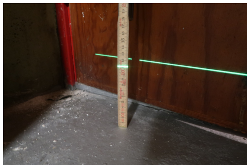
Måling av fallforhold ved innerdør, tilnærmet flatt
