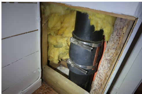
Bilde viser skjøting av avløpsrør i kjeller
