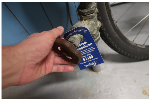
Bilde viser stoppekran
