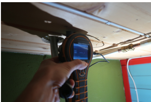
Bilde viser fuktmåling i gulvkonstruksjon
