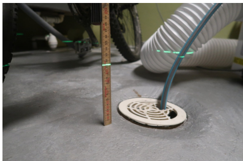
Måling av fallforhold ved sluk
