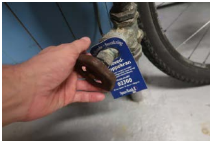
Bilde viser stoppekran
