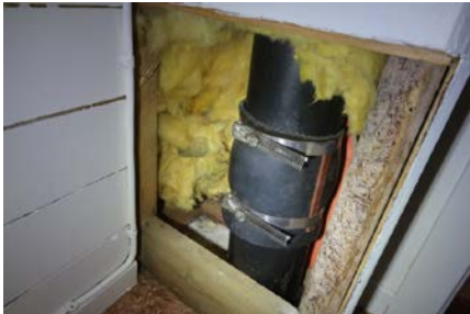
Bilde viser skjøting av avløpsrør i kjeller
