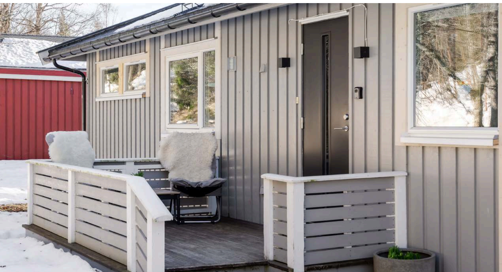
Inngangspartiet har en solid ytterdør med smalt glassfelt og terrasse i treverk.
