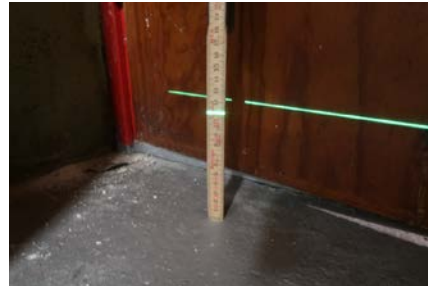
Måling av fallforhold ved innerdør, tilnærmet flatt
