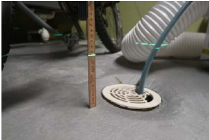
Måling av fallforhold ved sluk
