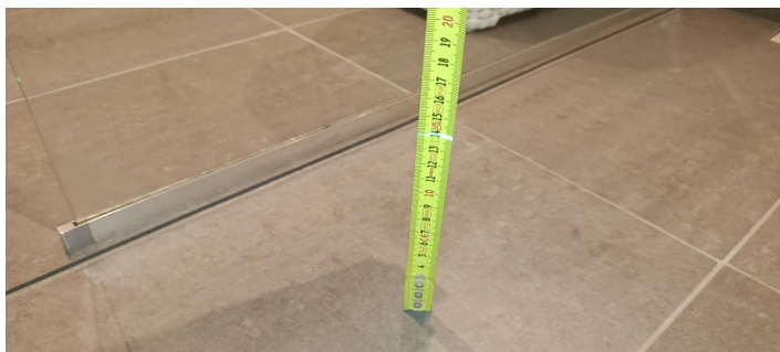
Kontroll av fall mot sluk.
