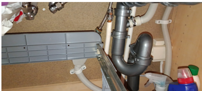
Kontroll av røropplegg.
