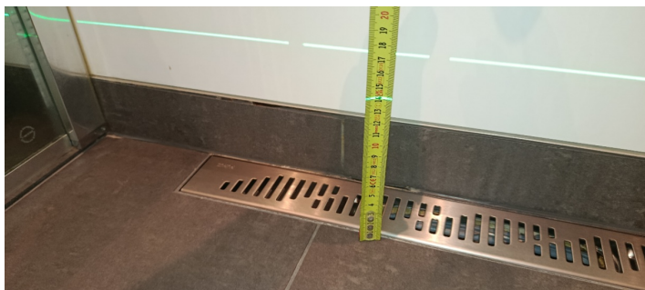
Kontroll av fall mot sluk.
