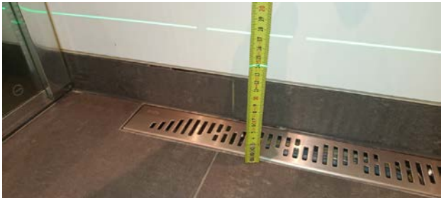
Kontroll av fall mot sluk.
