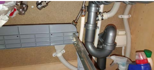
Kontroll av røropplegg.
