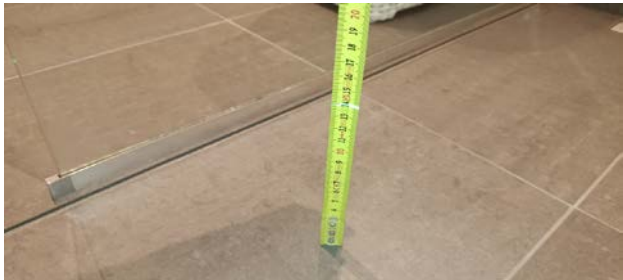
Kontroll av fall mot sluk.
