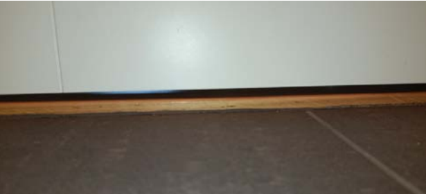
Kontroll av høyde på luftespalte under døren.
