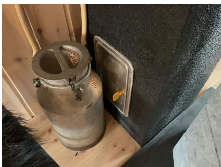
Sotluke plassert på stue.
