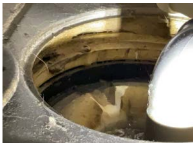
Membran er ført ned i sluk uten klemring.
