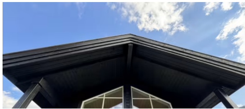
Synlig luftespalte mellom takrenne og pannebord.
