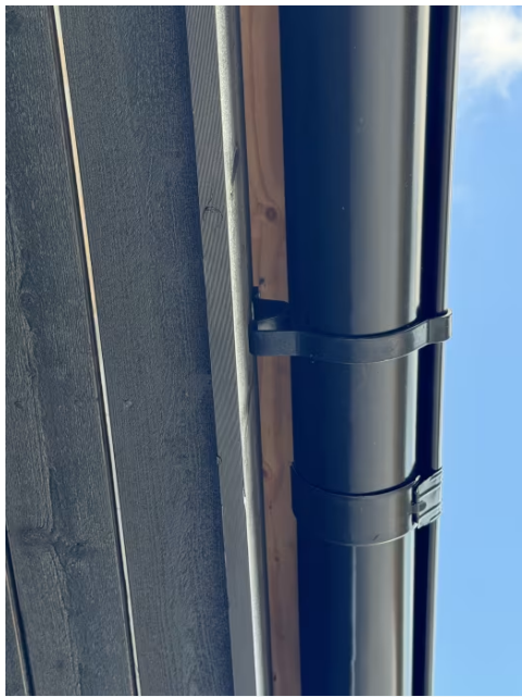
Synlig luftespalte mellom takrenne og pannebord.
