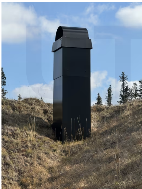
Helbeslått pipe over tak.
