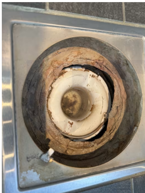
Synlig membran i sluk.
