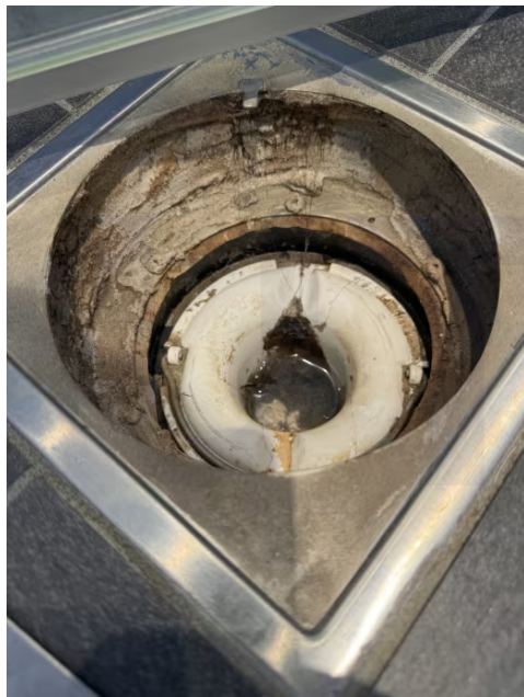
Synlig membran under klemring.
