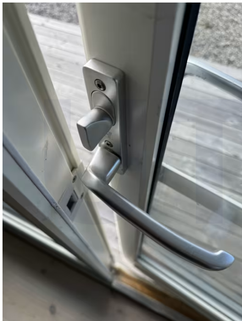
Terrassedøren er noe trang å lukke, vrider er løs og det trenges et mindre tiltak.
