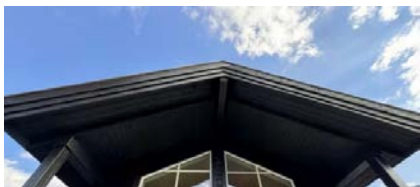
Synlig luftespalte mellom takrenne og pannebord.
