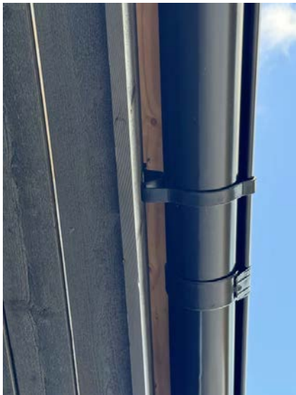
Synlig luftespalte mellom takrenne og pannebord.
