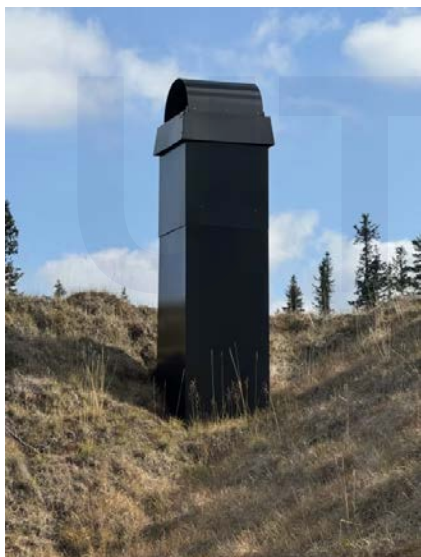
Helbeslått pipe over tak.
