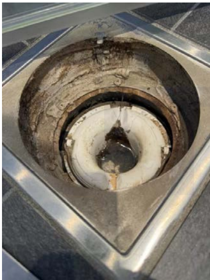
Synlig membran under klemring.
