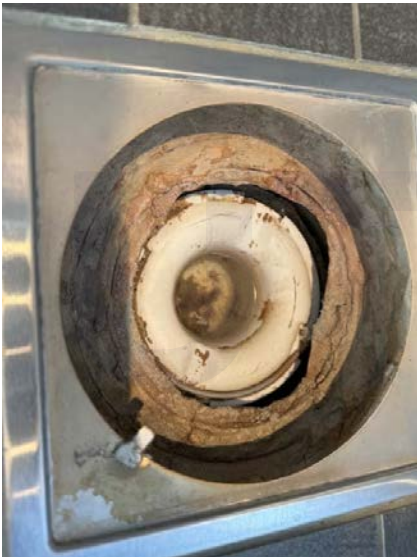
Synlig membran i sluk.
