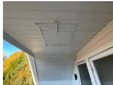
Ikke tilgang da luken er spikret fast.
