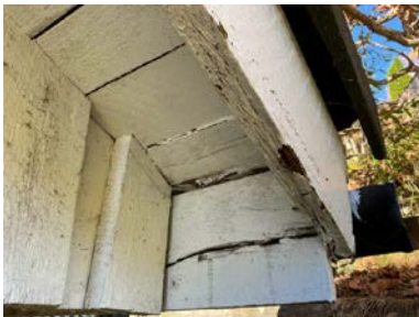
Bærende konstruksjoner er kuttet.
