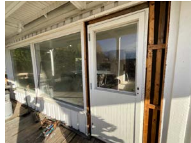
Døren mangler omramming og håndtak.
