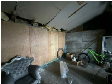
Bærende konstruksjoner er kuttet.
