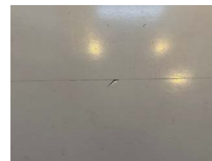
Hakk i gulv på kjøkken.
