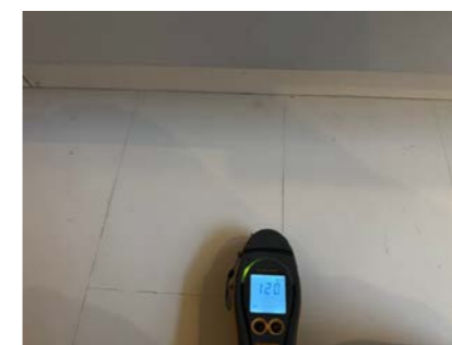
Ingen forhøyede fuktverdier ble registrert i kjøkkenbenken.
