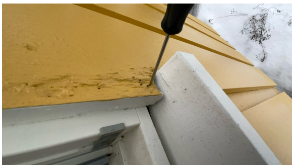
Råte panel vindu 2 etg nor vest
