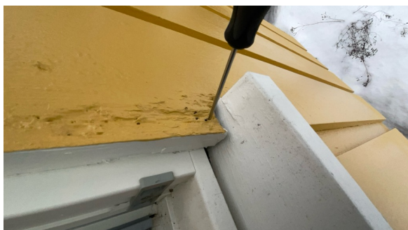
Råte panel vindu 2 etg nor vest
