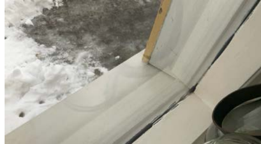
Manglende dryppkant vindu stue. Fuktskader foring vindu stue.
