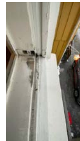
2 etg utleie trege, slitt uten dryppkant. Eldre vinduer syd
