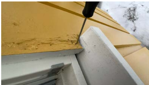
Råte panel vindu 2 etg nor vest
