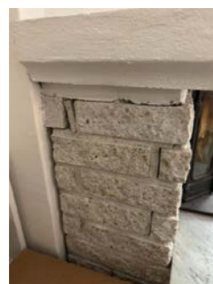
Sprekker på siden av peisomramning i Mexistein
