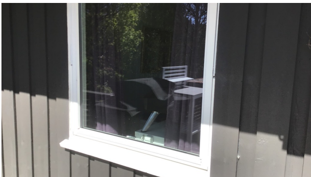
Nye vinduer på baksiden
