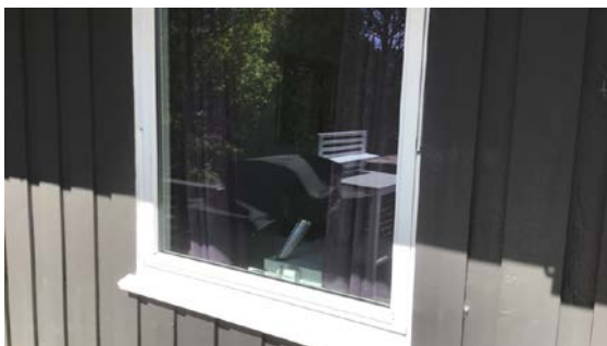
Nye vinduer på baksiden
