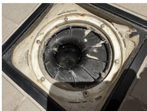
2-delt sluk med membran under klemring.
