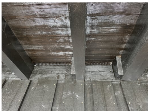
Synlig lufting av takkonstruksjon.
