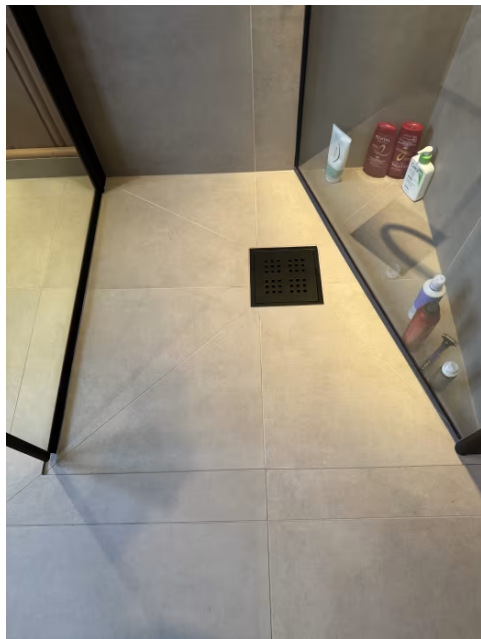
Dusjsone med nye fliser.
