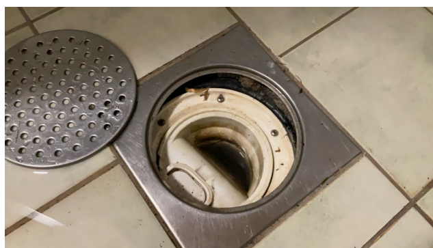
KJELLERETASJE/U. ETASJE > BAD/WC
