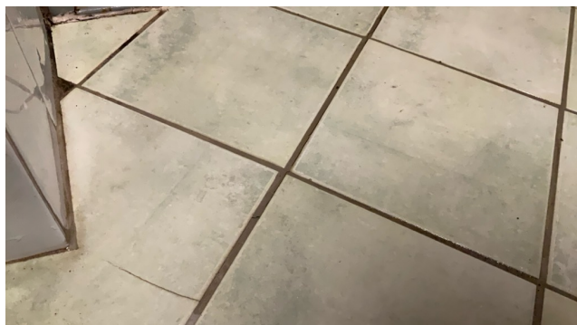
KJELLERETASJE/U. ETASJE > BAD/WC
