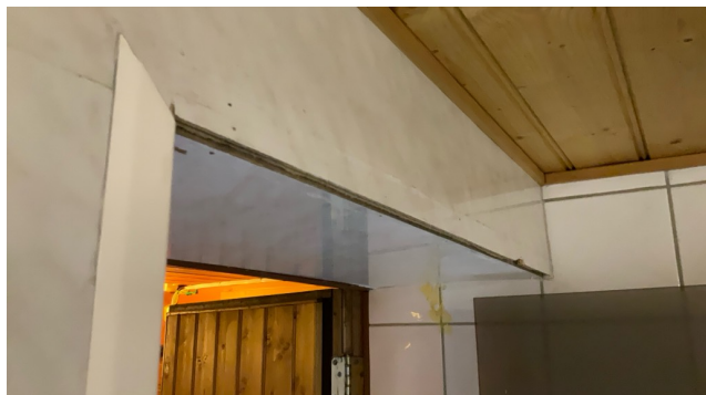
KJELLERETASJE/U. ETASJE > BAD/WC
