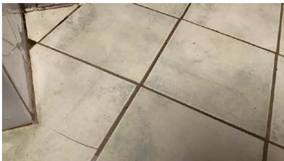
KJELLERETASJE/U. ETASJE > BAD/WC
