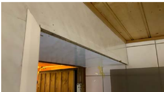
KJELLERETASJE/U. ETASJE > BAD/WC
