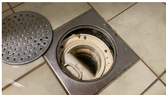
KJELLERETASJE/U. ETASJE > BAD/WC
