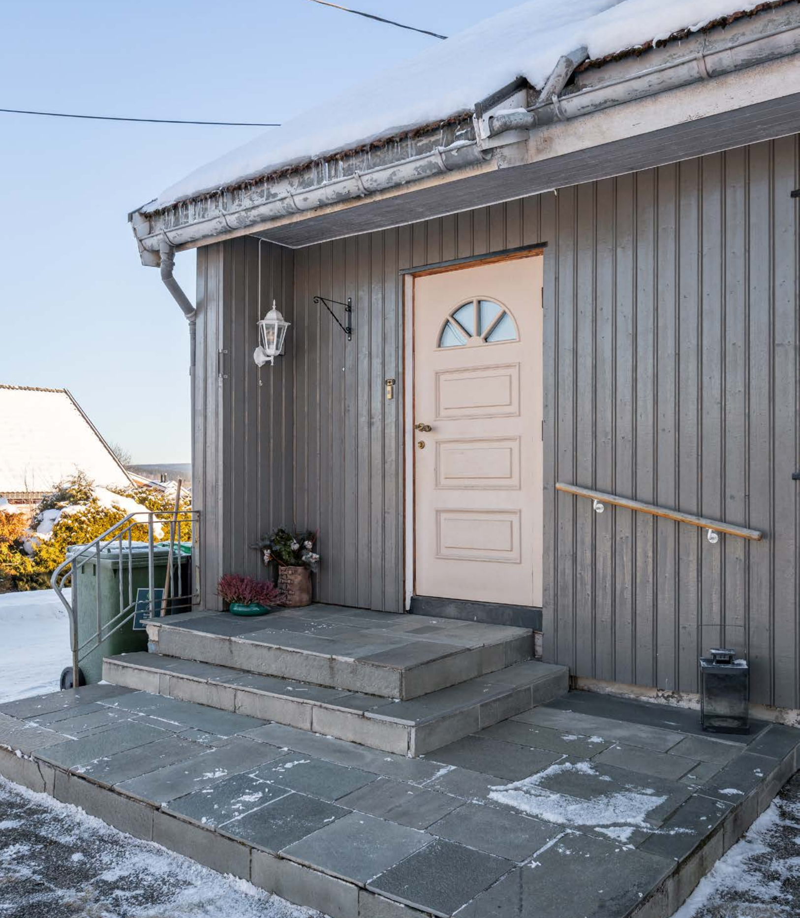
Det overbygde inngangspartiet har hellelagt adkomst og støpt, skiferlagt trapp.
