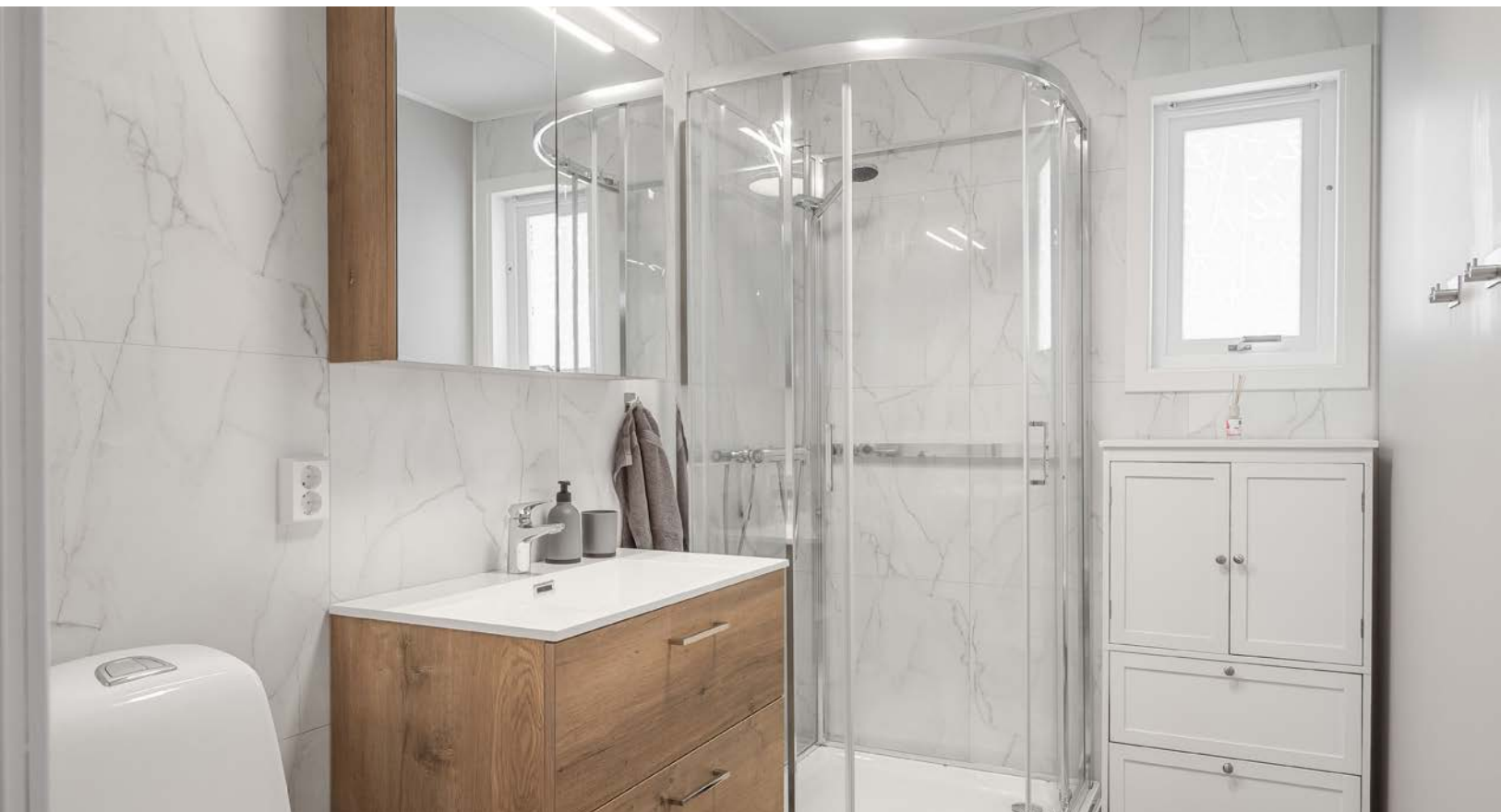
Lyst og delikat baderom som ble pusset opp i 2025. Badet har våtromsbelegg på gulv med gulvvarme, lyse våtromsplater på veggene og mekanisk avtrekk.
