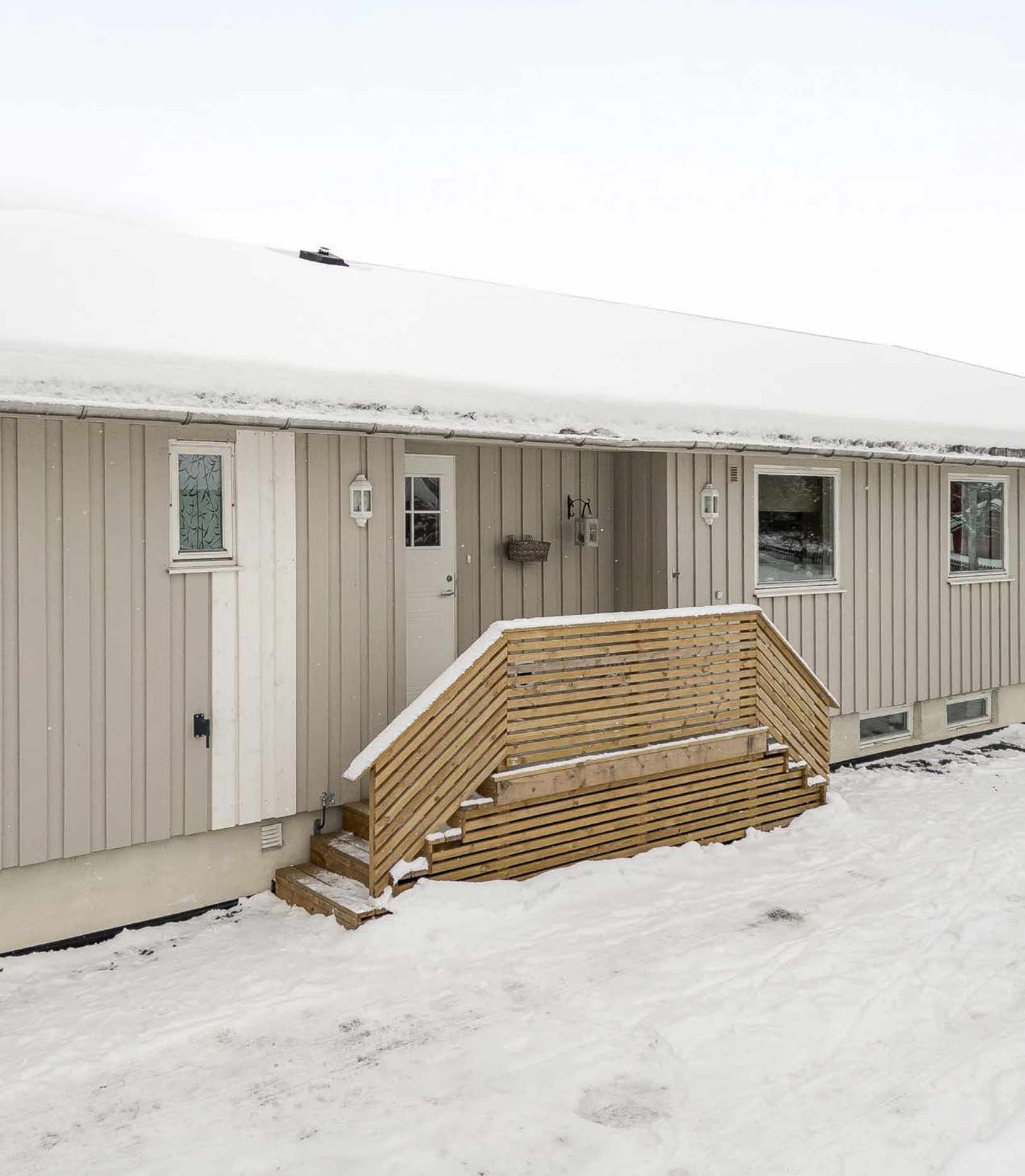
Det ble bygget ny trapp ved inngangspartiet i 2025.
