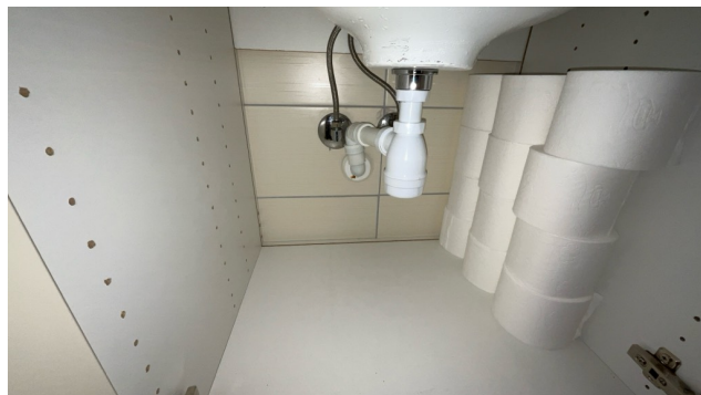
Besiktigelse av røropplegg.
