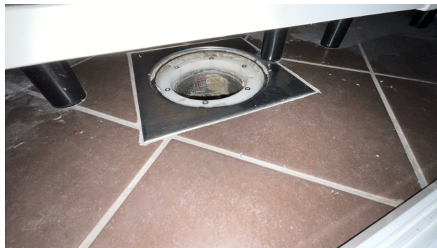
Kontroll av sluk.
