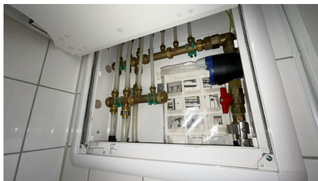
Besiktigelse av røropplegg.
