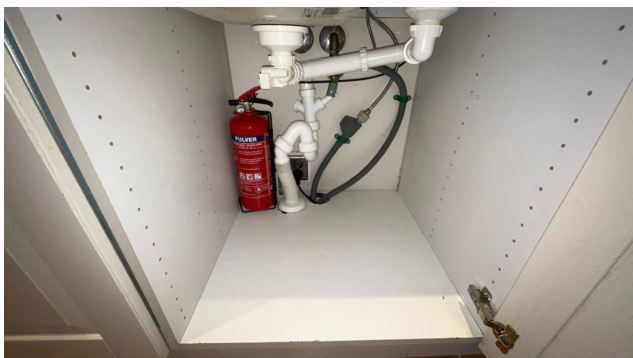
Besiktigelse av røropplegg.
