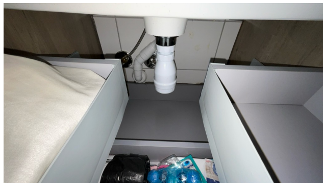
Besiktigelse av røropplegg.
