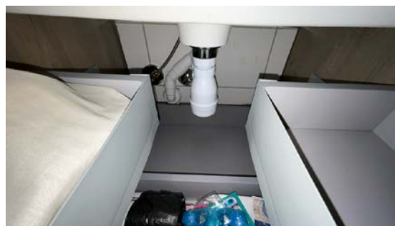
Besiktigelse av røropplegg.
