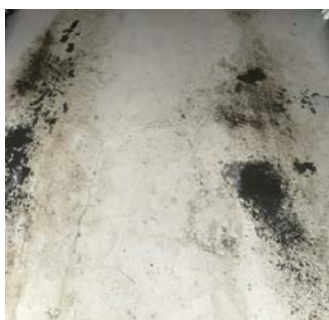
Synlig riss på betongsålen.
