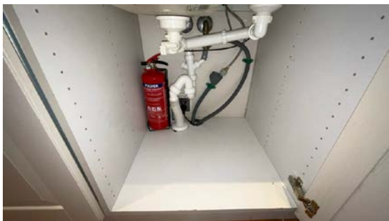
Besiktigelse av røropplegg.
