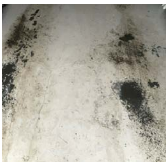
Synlig riss på betongsålen.
