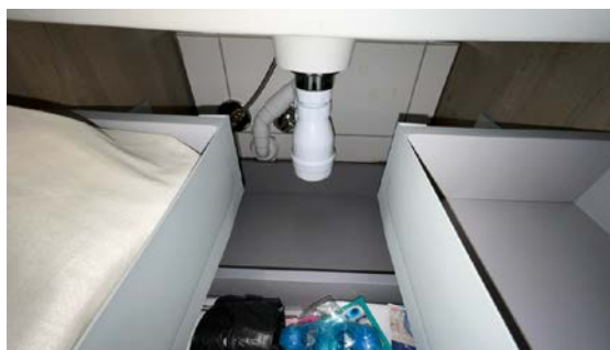
Besiktigelse av røropplegg.
