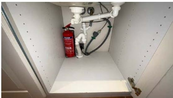
Besiktigelse av røropplegg.
