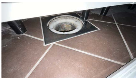
Kontroll av sluk.
